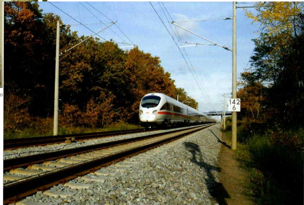
Bild 1: Die Streckengleise Hamburg-Berlin nach dem Umbau
